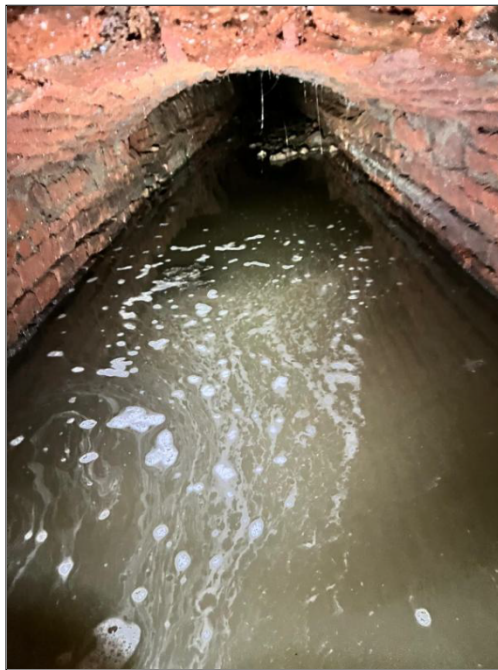
Tram de galeria amb sostre de material ceràmic (63 cm d'alçada x 120 cm d'ample)
