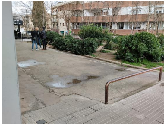
Paviment a enderrocar
