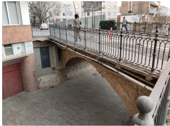
Instal·lació d'aigua potable vista, fins arribar al parterre
