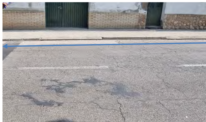
Imatge del tram de carrer asfaltat amb instal·lacions existents a tenir en compte
