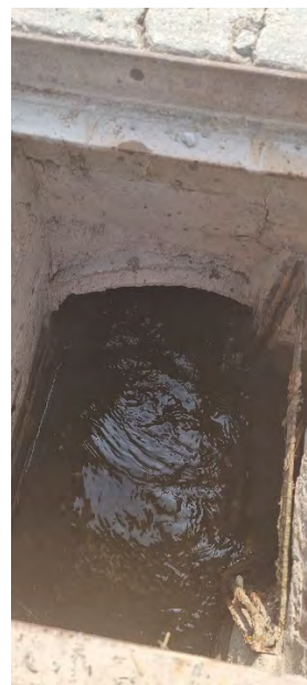
Imatge del reg de soterrat a tenir en compte per fer la rasa
