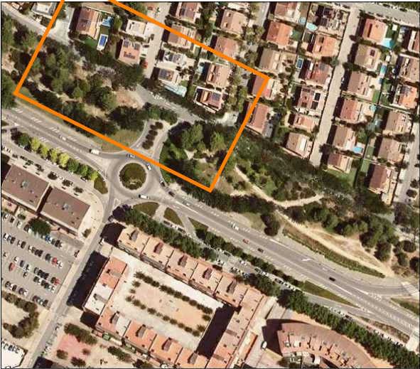
ORTOFOTO (ICC) TRAM AFECTAT
