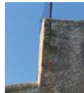
Foto n°1. Esquerda del mur al pk 14+640
