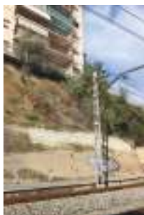
Foto n°6. Tram entre el PK 14+950 i el 14+960
