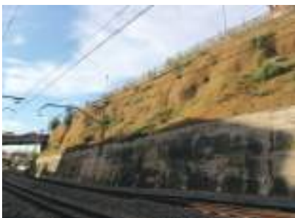
Foto n°5. Actuació d'estabilització al 2016 de geomalla i mala de fil d'acer.
