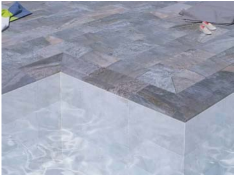
Piscina desbordante con Rejilla Invisible
