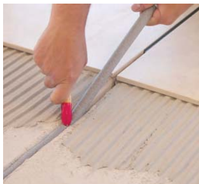
Encobrir el SELLALASTIC FOAM en la junta de dilatació amb una fusteta.
