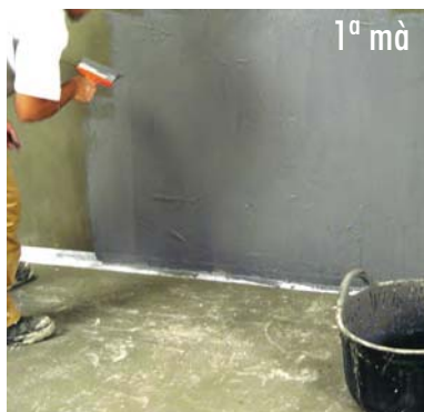
Aplicació de la 1ª mà de HIDROELASTIC .
