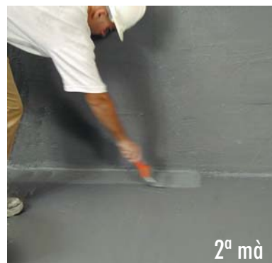
Aplicació de la 2ª mà de HIDROELASTIC .
