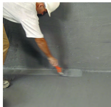
Aplicació de la 2ª mà d'HIDROFIX.
