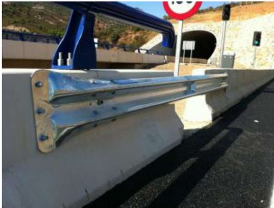
Figura 9. New Jersey habilitat amb forat per a drenatge transversal
