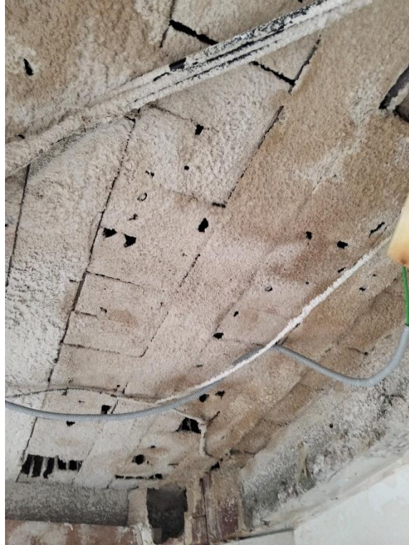
Imatge 2: Forjat bigueta ceràmica armada
