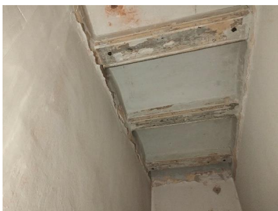
Imatge 3: Forjat de bigueta de fusta i volta a la catalana
