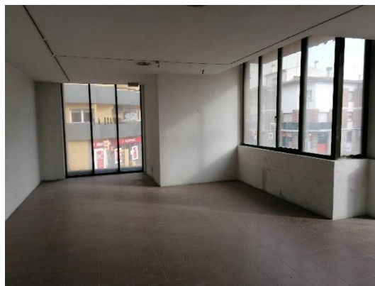
Zona C – planta primera. Façana en cantonada entre el carrer Raimon d'Abadal i el passeig de la Generalitat. Futura consulta B08.
