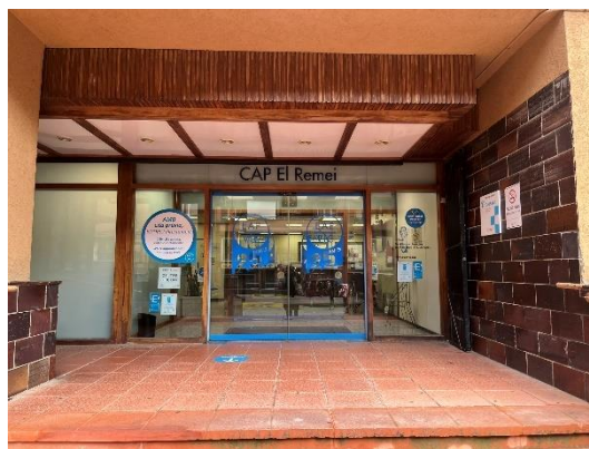
Zona A – fusteria a substituir E33, E34 i E35.
