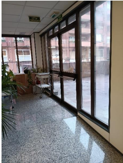
Zona A – fusteria a substituir E23 des de l'interior.
