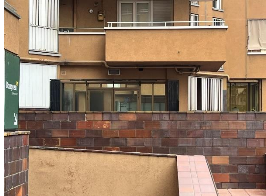
Zona A – fusteria a substituir E23.
