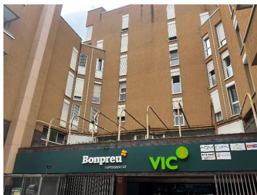
Zona C – fusteria a substituir E01 i E02.
