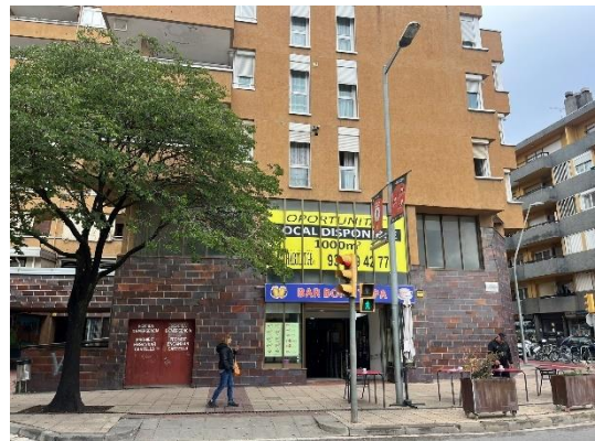
Zona C – fusteria a substituir E06, E07 i E08.
