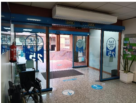
Zona A – fusteria a substituir E35 des de
