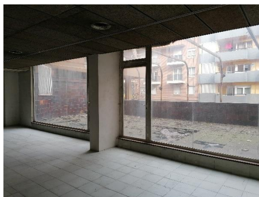
Zona C – planta primera. Espai d'accés i connexió amb la terrassa del carrer Raimon d'Abadal. Futures espais B03, C05 i B04.
