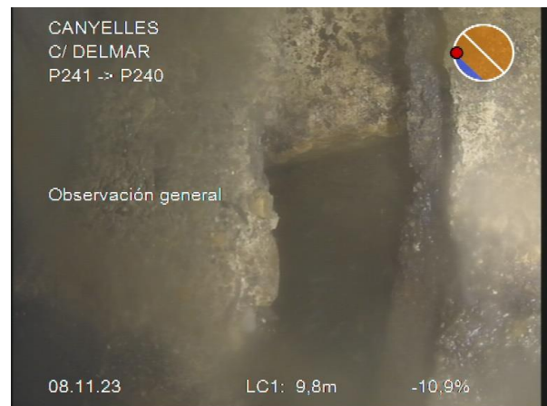
P241-P240_0d3e9cc1-c73e-4dc2-aae7-12d908de82d6_20231108_094836_405.jpg, 00:05:03, 9.80m Observación general / JUNTA SEPARADA
