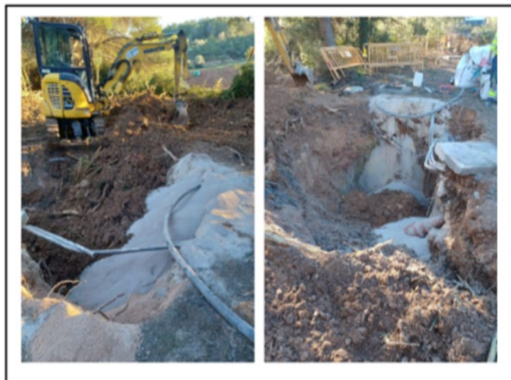
Imatge 7. Cobriment de la canonada i el dipòsit amb sorra fina
