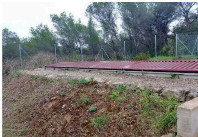
Imatge 10. Fotografia del 2022, lateral del talús que pot haver provocat la inclinació dels biodiscs
