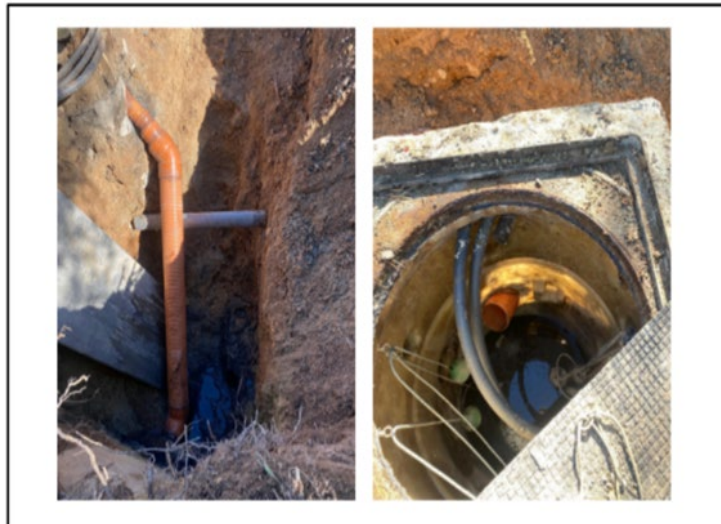
Imatge 5. Instal·lació de la nova canonada de PVC reforçat
