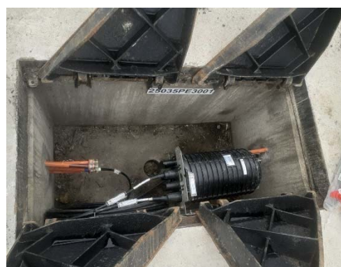
Exemples d'instal·lació de Caixes d'Empulament dins de Pericó (En pericons C pot ubicar-se en horitzontal i vertical, per a pericons C2 sempre en horitzontal)
