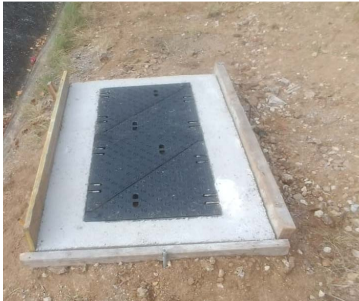
Exemple pericó tipus C2 amb marc d'encofrat de formigó
