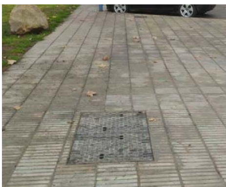
Exemple pericó tipus C2 en Vorera
