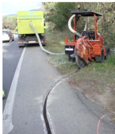
Gir de sortida de la calçada per col·locació d'un pericó
