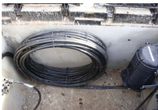
Exemples d'instal·lació de Caixes d'Empulament dins de Pericó (En pericons C pot ubicar-se en horitzontal i vertical, per a pericons C2 sempre en horitzontal)
