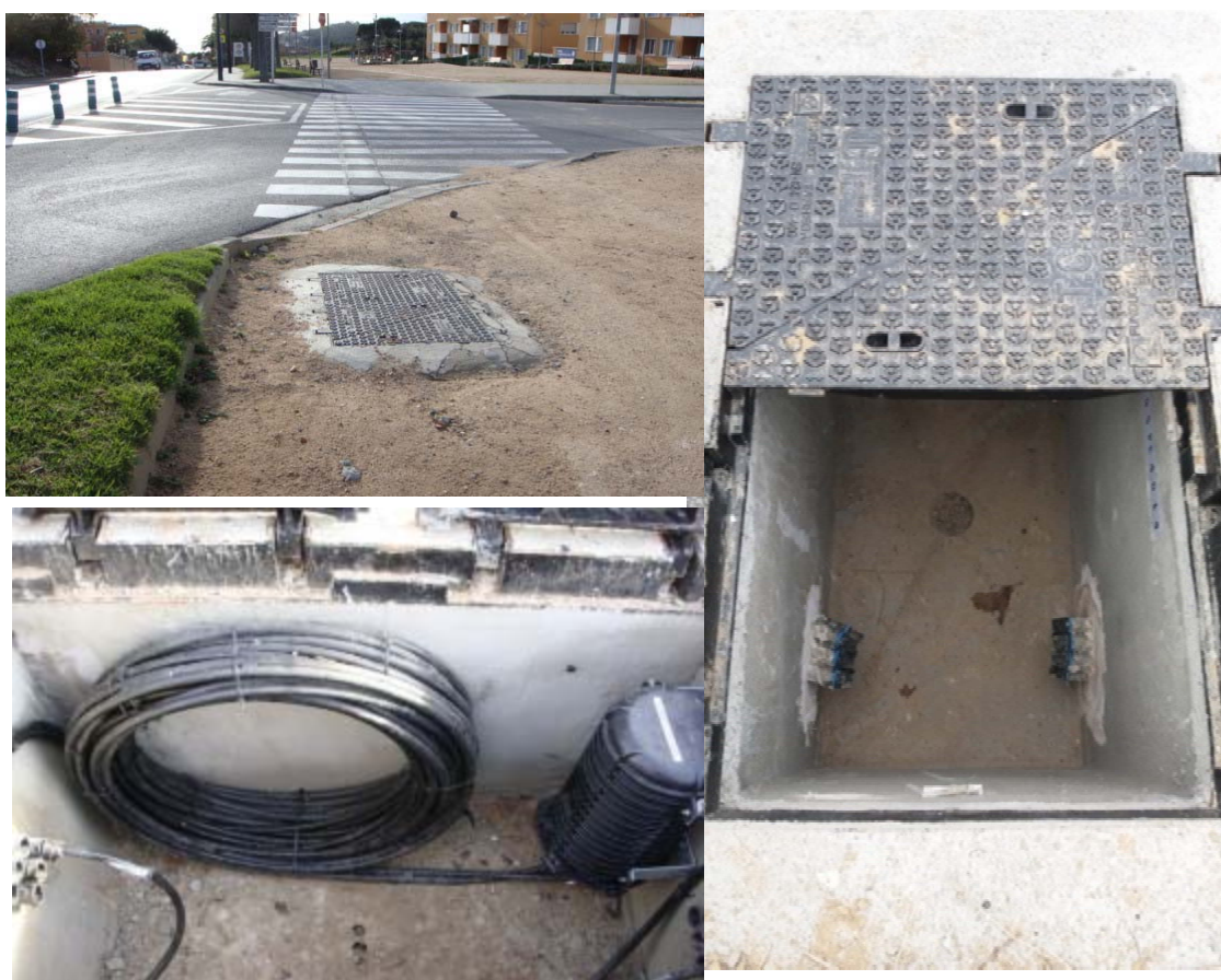
Detall interior pericons tipus C
