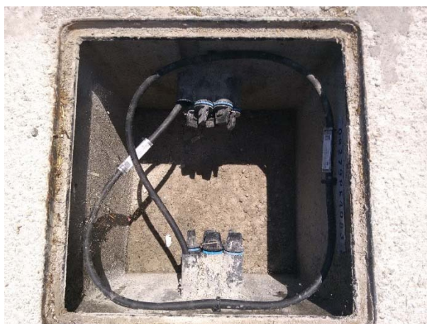
Exemple de pas de cable per pericó
