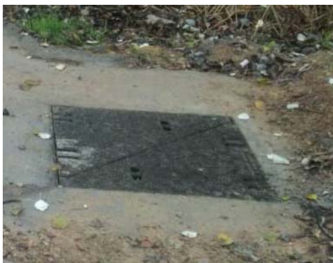
Exemple pericó tipus B2 en terres
