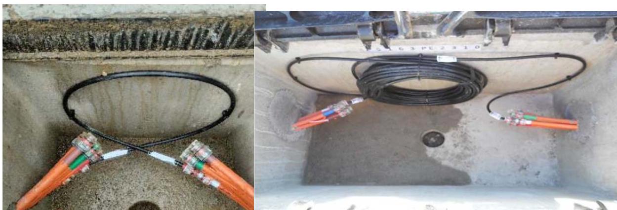
Exemples Terminació microductes en pericó
