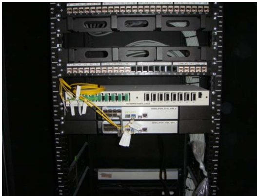
Exemples d'instal·lació de Repartidor de Fibra Òptica
