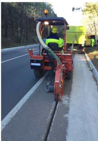
Exemple de treballs d'obertura de la microrasa
