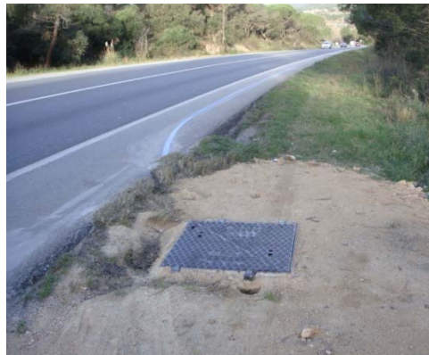
Exemple de l'estat de la canalització acabada
