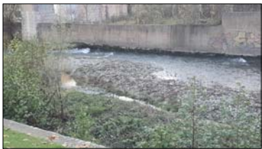
acumulació de sediments que provoca una innecessària erosió del mur de contenció oest 289 m2 / gruix mitjà: 30 cm
