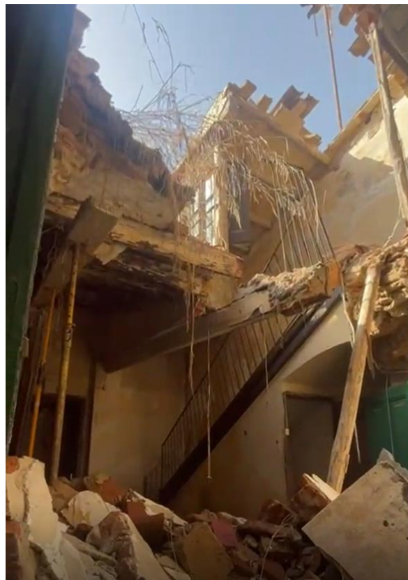
Estat de l'interior
