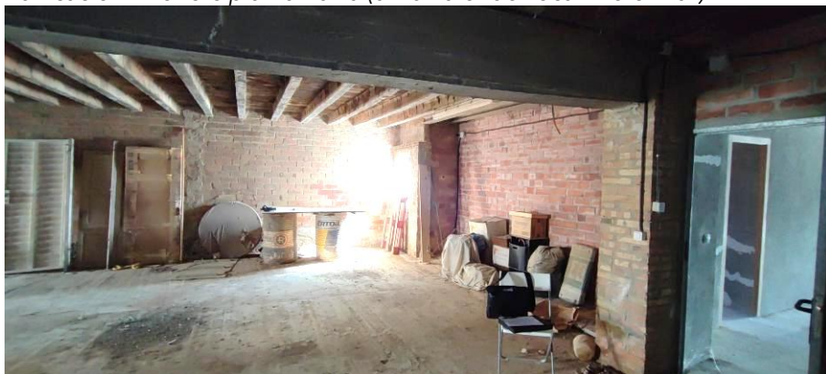
Edificació - interiors planta Baixa (àmbit a enderrocar i reformar)
