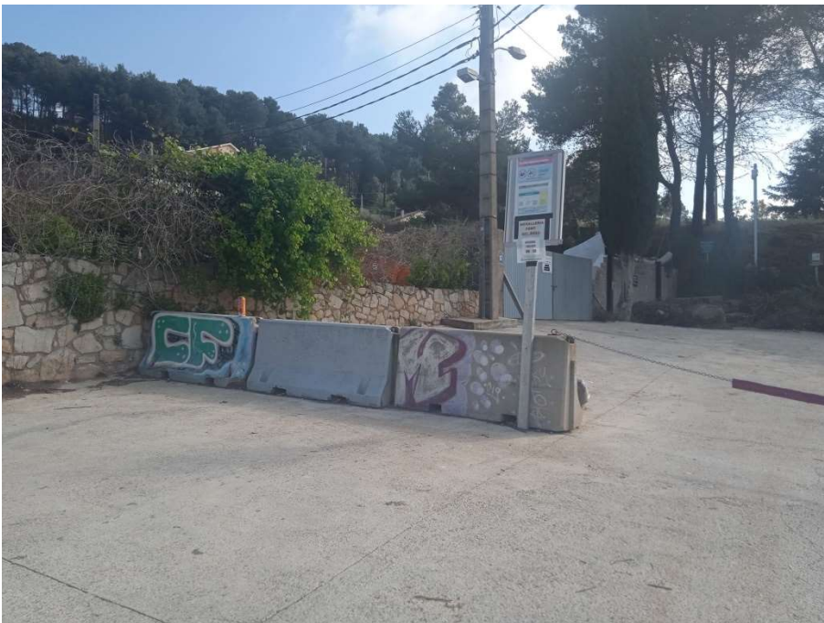
zona accés des de l'exterior on veu la porta que limita l'espai obert i tancat en aquest moment i que anirà fora per l'ampliació de la deixalleria.
