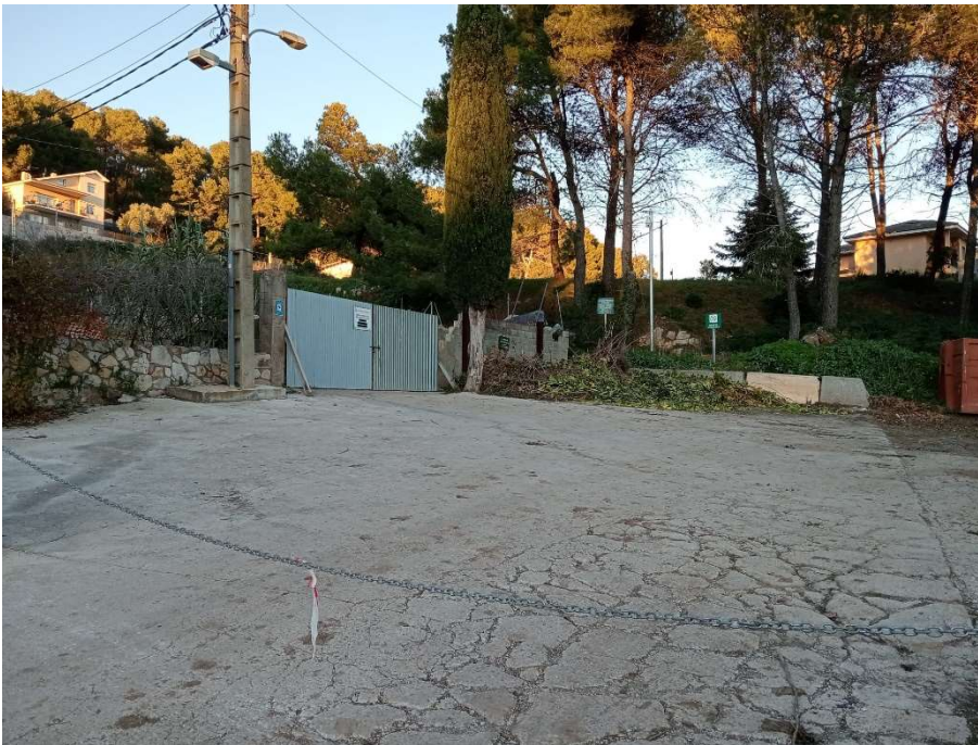
Fotografia de la zona del paviment a reparar
