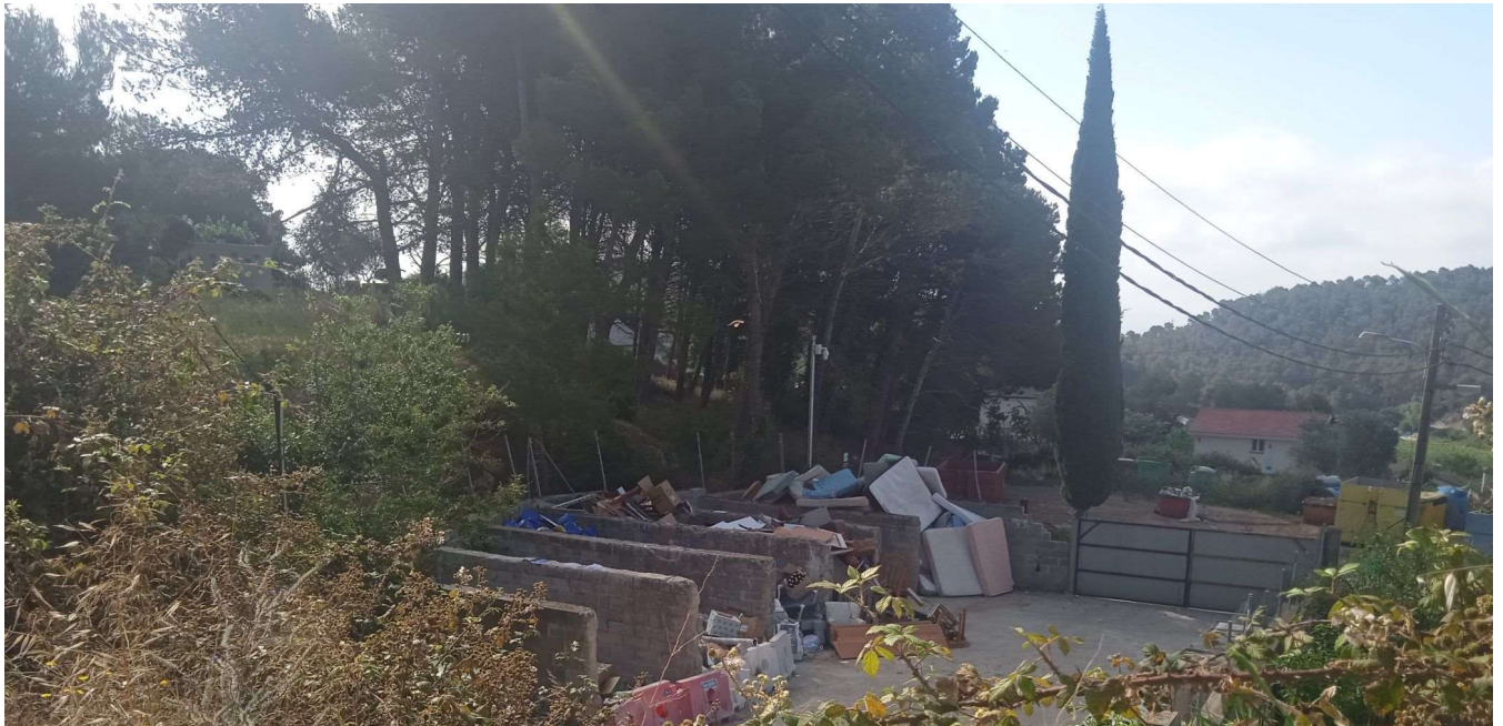
Vista des del carrer Indústria on es veu la zona de la deixalleria ara tancada i pavimentada i al fons la zona a ampliar i pavimentar
