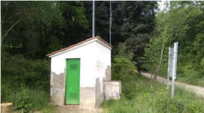
Font: Pla Director del Servei Municipal d'Abastament d'aigua. Captació Pou de la Casica
