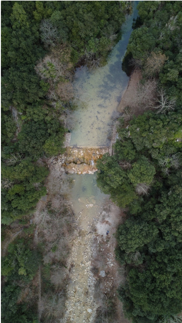
Figura 2. Imatge aèria de la resclosa del Gomarell.
