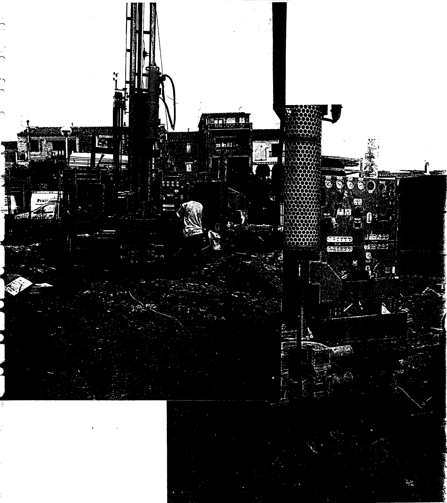
Fotografies de l'emplaçament i durant l'assaig de penetració dinàmica en continu PD-1 amb una fondària de reconeixement assolida de 1,99 m obtenint el rebuig de l'assaig que es relaciona amb la localització de la unitat detrítica de compacitat alta en la fondària de reconeixement.
