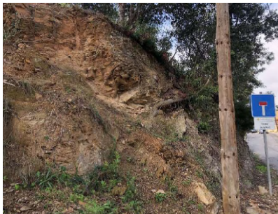
Fotografia 3: Vista dels materials del talús del carrer de la Font. Poc foliat.
