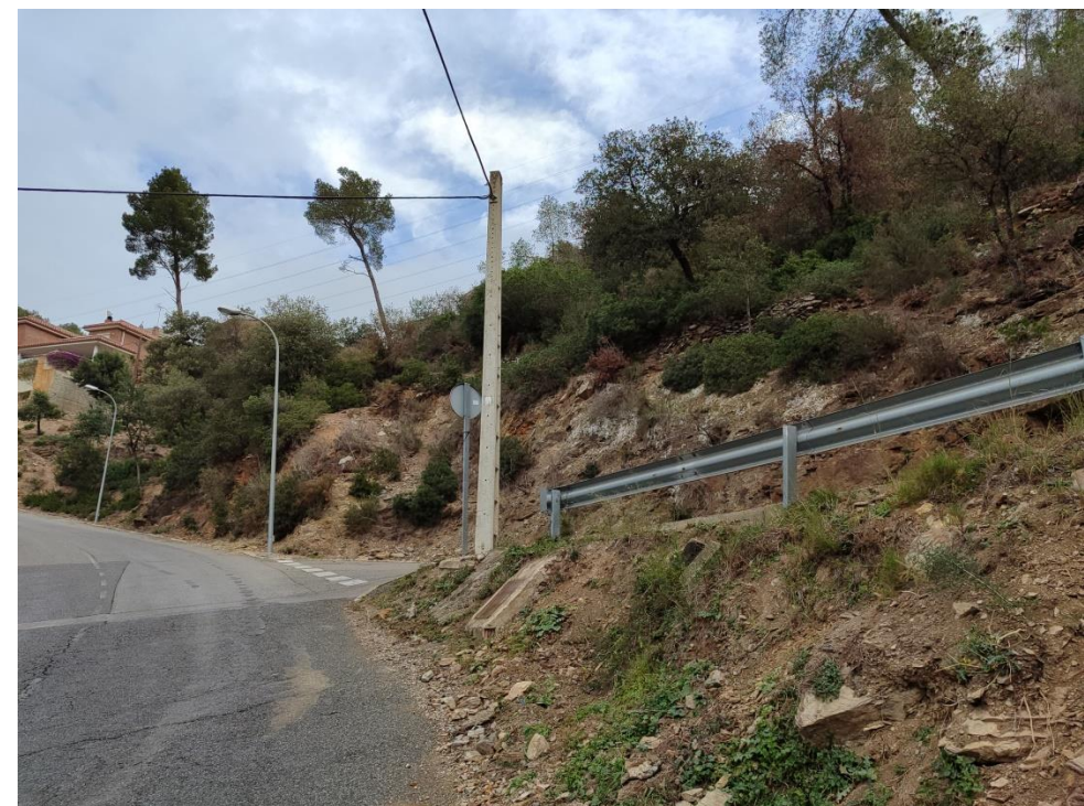
Fotografia 6. Pal de formigó - Xarxa de telefonia a l'àmbit de projecte
