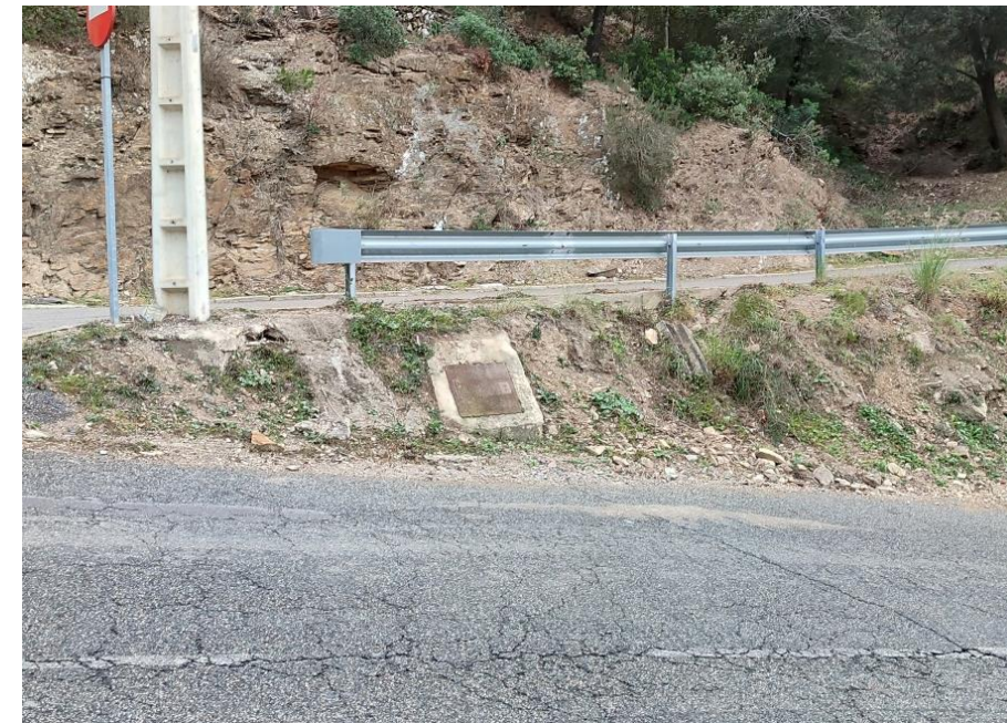
Fotografia 7. Pou de registre en talús
