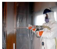
Figura 7. Procediment de neteja amb raig de gel
