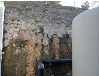
Marques de circulació d'aigua en el mur.
