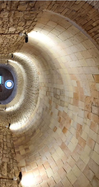
La instal·lació no és la més adequada per a un recinte històric. La il·luminació tenia els plans expositius. A la capella es desapareixien les cornises laterals com a zona d'inclusió de la il·luminació indirecta. El punt al costat de la volta havia de ser eliminat.
