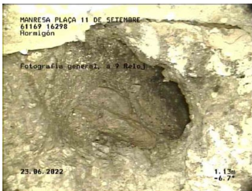
Figura 8. Col·lector punt de ruptura.
