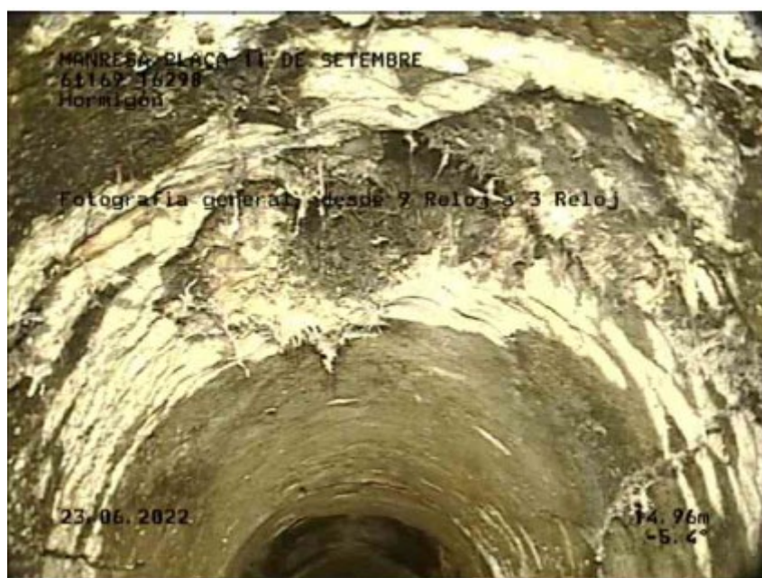
Figura 9. Col·lector a on es mostra el fresat que s'ha realitzat de les arrels.
