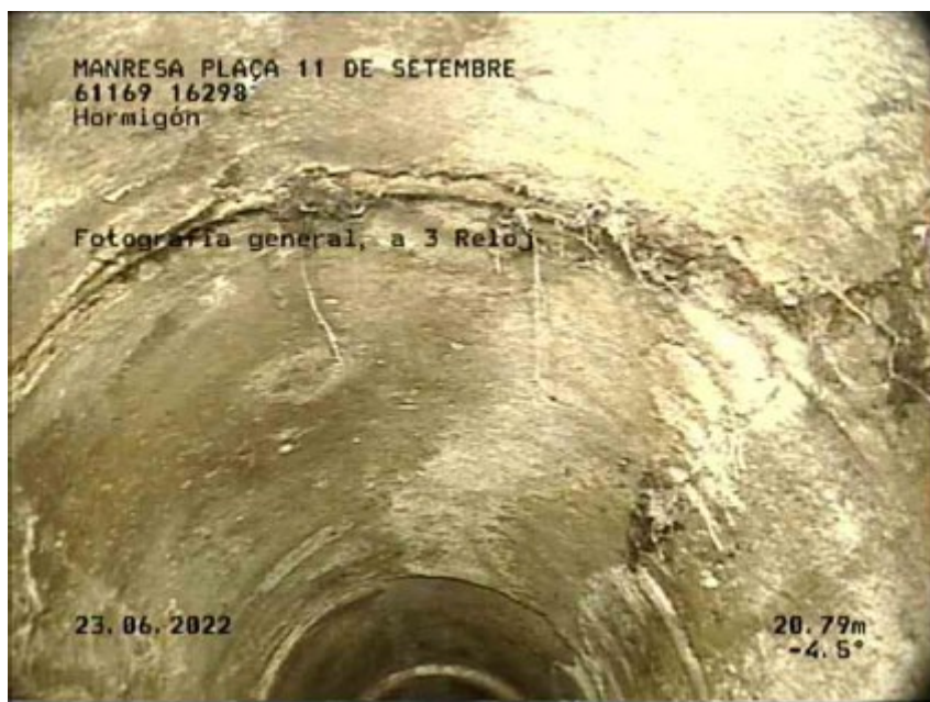
Figura 11. Col·lector a on es mostra el fresat que s'ha realitzat de les arrels.
