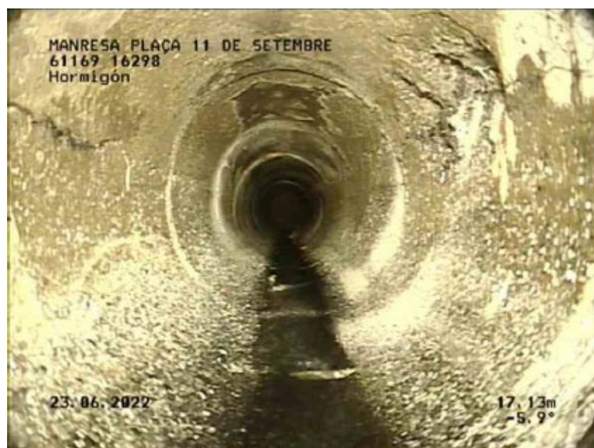
Figura 10. Col·lector a on es mostra el fresat que s'ha realitzat de les arrels.
