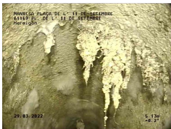
Figura 2. Col·lector presència arrels.
