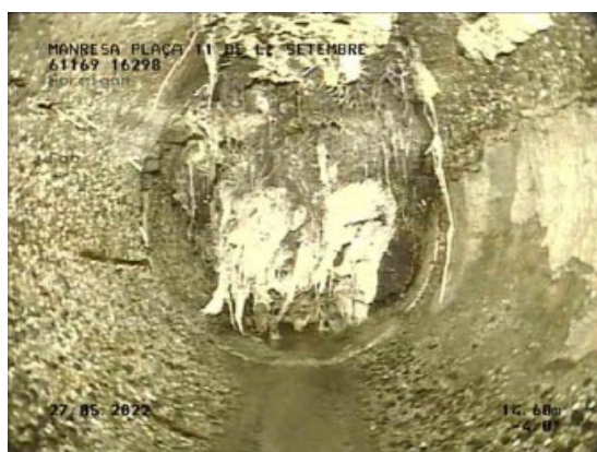
Figura 4. Col·lector presència arrels.
