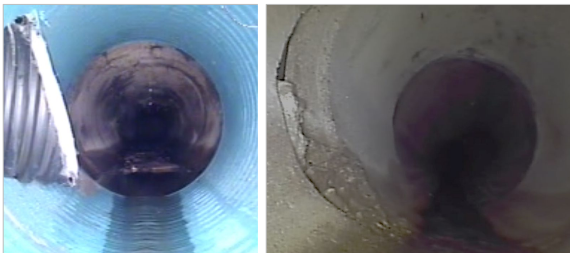
Figura 3. Col·lector P21290-P21299, canvis de material i diàmetre
