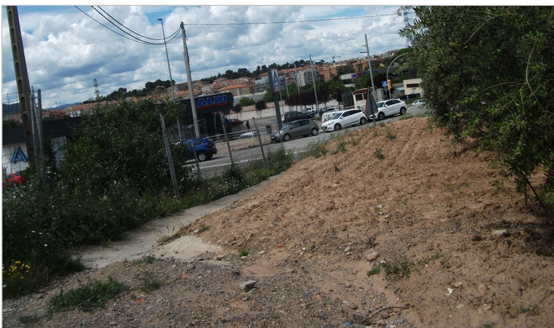
Fotografia 12. Recorregut PVC-400 fins a canal de formigó i connexió pou P22256.
