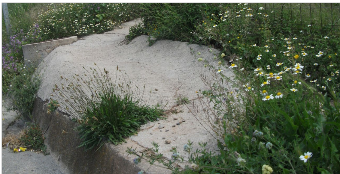
Fotografia 10. Canal de formigó en àmbit d'actuació tram 3.
