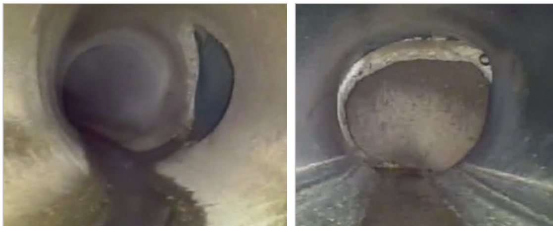
Figura 2. Connexió pou de registre P21299 vista des del col·lector sud (esquerra) i des del col·lector nord (dreta)
