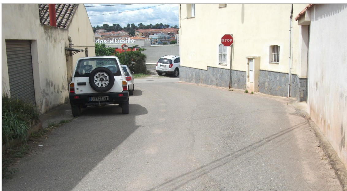
Fotografia 6. Recorregut galeria d'obra 200x200 fins a inici tram 2.
