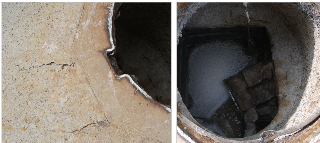
Figura 4. Obra civil (esquerre) i configuració interior (dreta) de l'arqueta C4.
