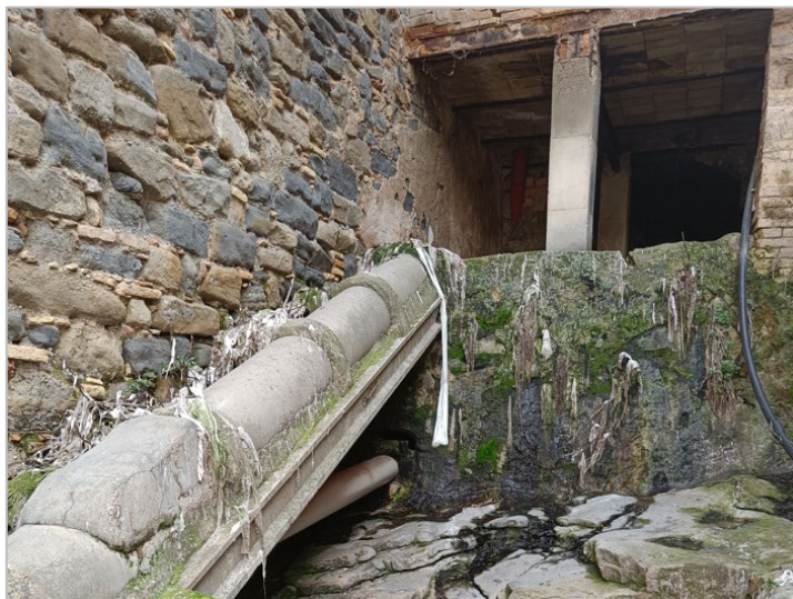
Figura 6. Connexió sota la galeria amb PVC-200 mm
