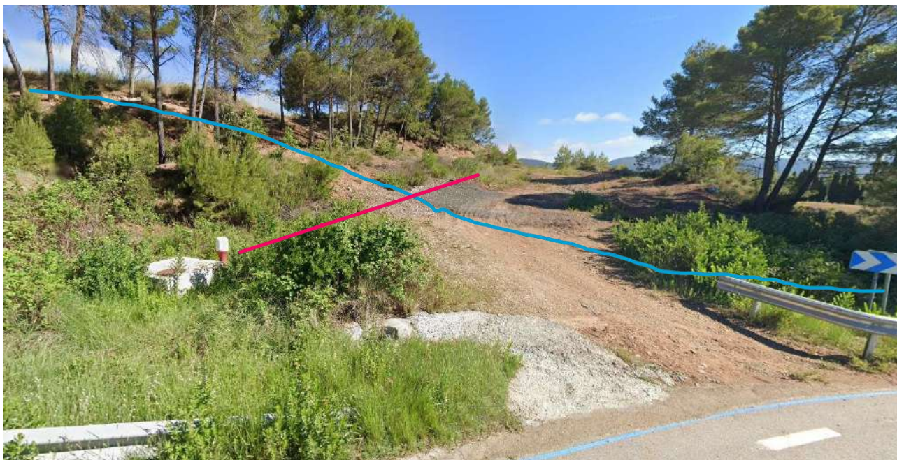
Il·lustració 11: Arqueta de la infraestructura Llosa del Cavall
