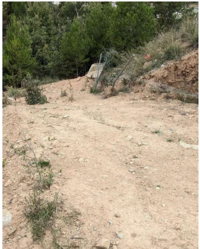
Il·lustració 9: Pou sud de creuament de la C-25 i inici de l'actuació
