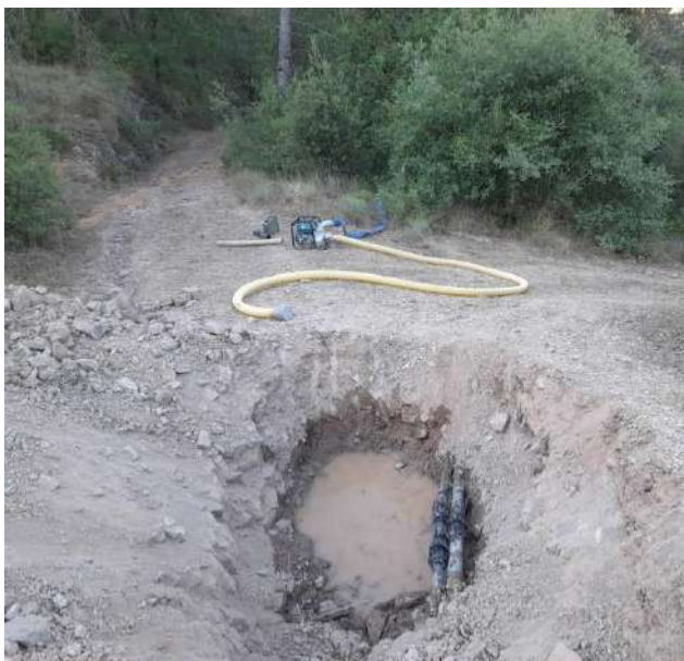
Il·lustració 3: Punt d'entrada de sistema hidrodinàmic
