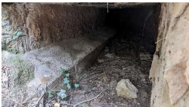
Il·lustració 12: Massissat de protecció de la beina
