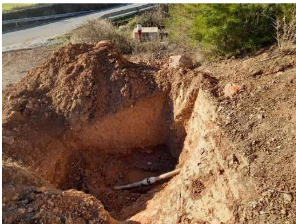
Il·lustració 2: Reparació ruptura tub
