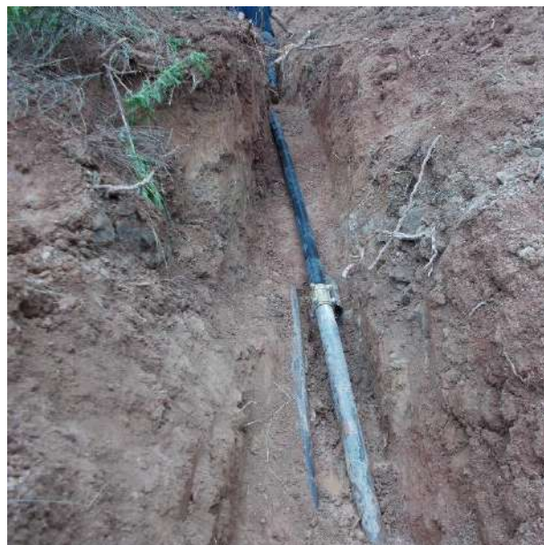
Il·lustració 4: Substitució de canalització
