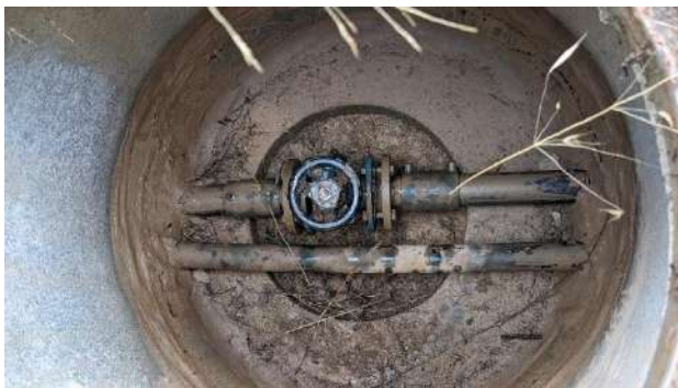
Il·lustració 16: Interior arqueta al costat de la carretera BV-1033. PK0+025
