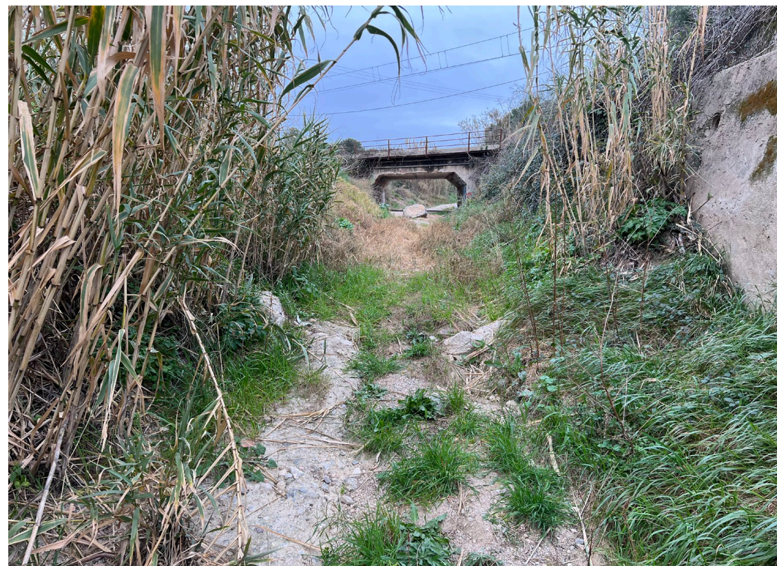
Foto. Tram del barranc entre vies, amb el pont del ramal nord del FFCC. Font: ©Eduardo Soler
