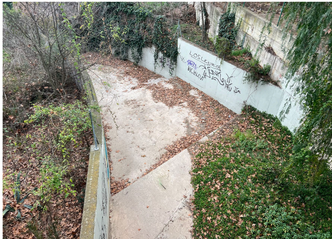
Foto. Aspecte del barranc, amb una obra de fàbrica pavimentada, al sud del Passeig de la Boca de la Mina. Font: ©Eduardo Soler
