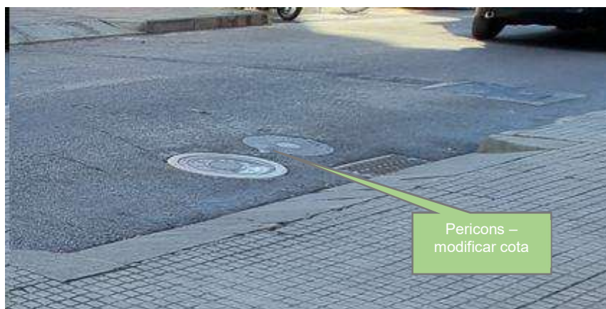
Pericons existents a adaptar a cota existent
