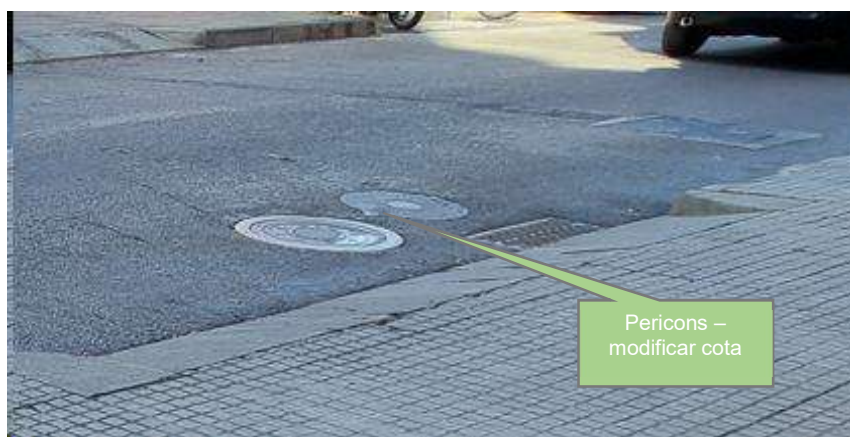
Pericons existents a adaptar a cota existent
