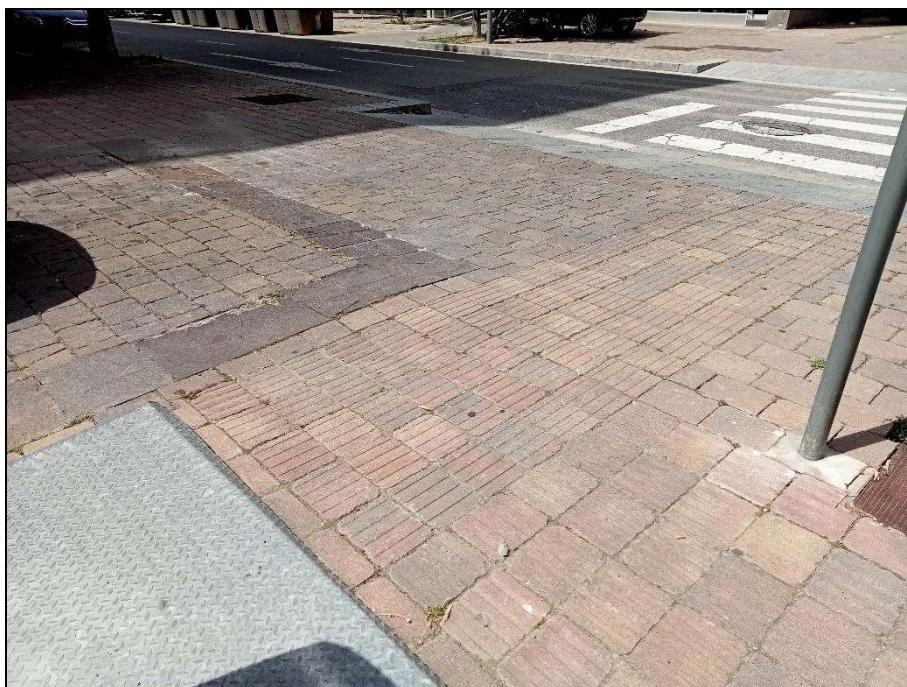
Tram ranurat a conservar – vorera sud
