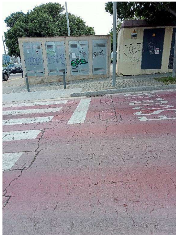
Vorera sud – quadres elèctrics existents
