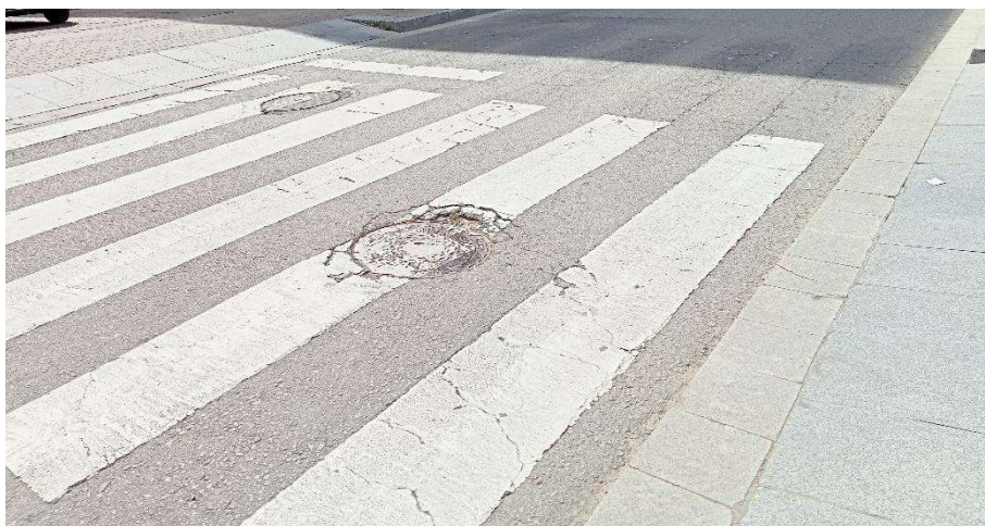
Pous clavegueram – adaptar cota a la de pas elevat
