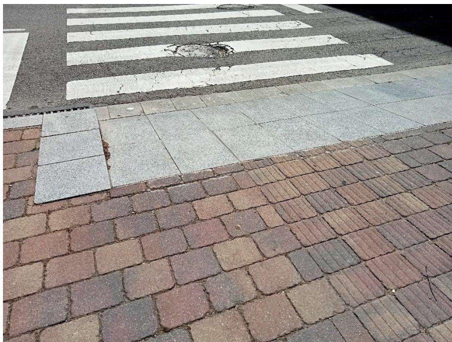
Vorera nord – gual a demolir / ranurat a mantenir
