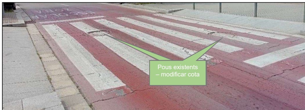
Pous existents a adaptar a cota existent
