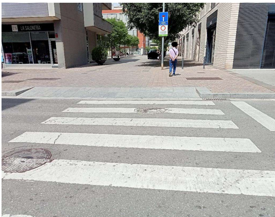
Pous clavegueram – adaptar cota a la de pas elevat
