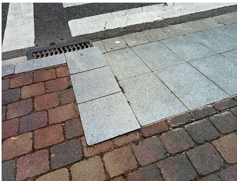
Vorera nord – gual a demolir
