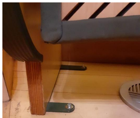
Platina de fixació a terra butaca Sala 1
