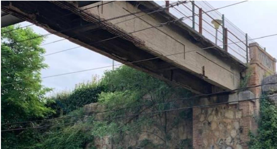
Figura 3. Imatge de l'estat actual del pont.
