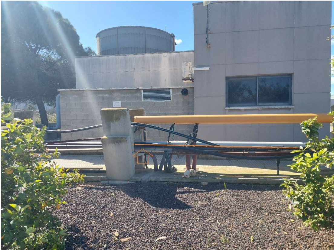
Foto Núm 3: Rac per instal·lar nova canonada
