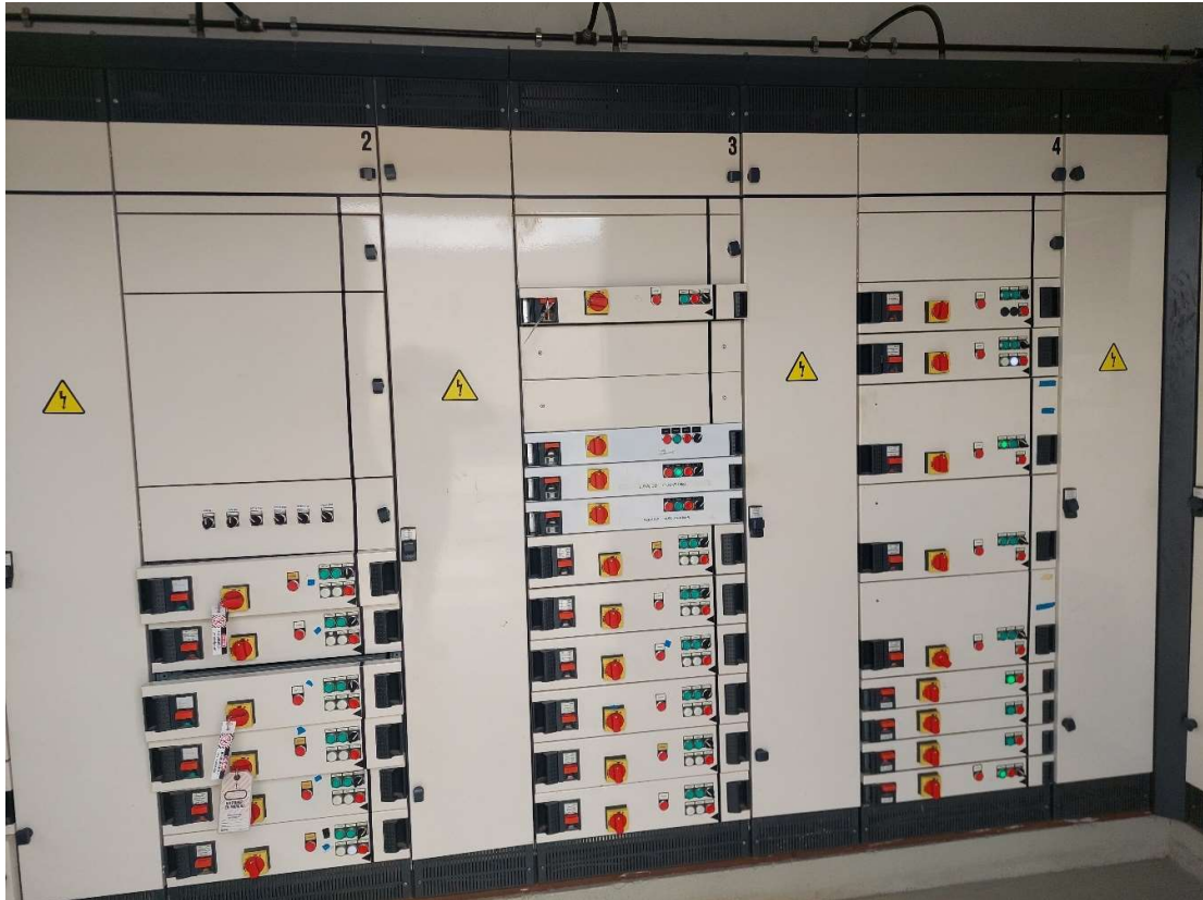
Foto Núm 11: Connexió elèctrica amb cubicle de potencia i senyals al plc
