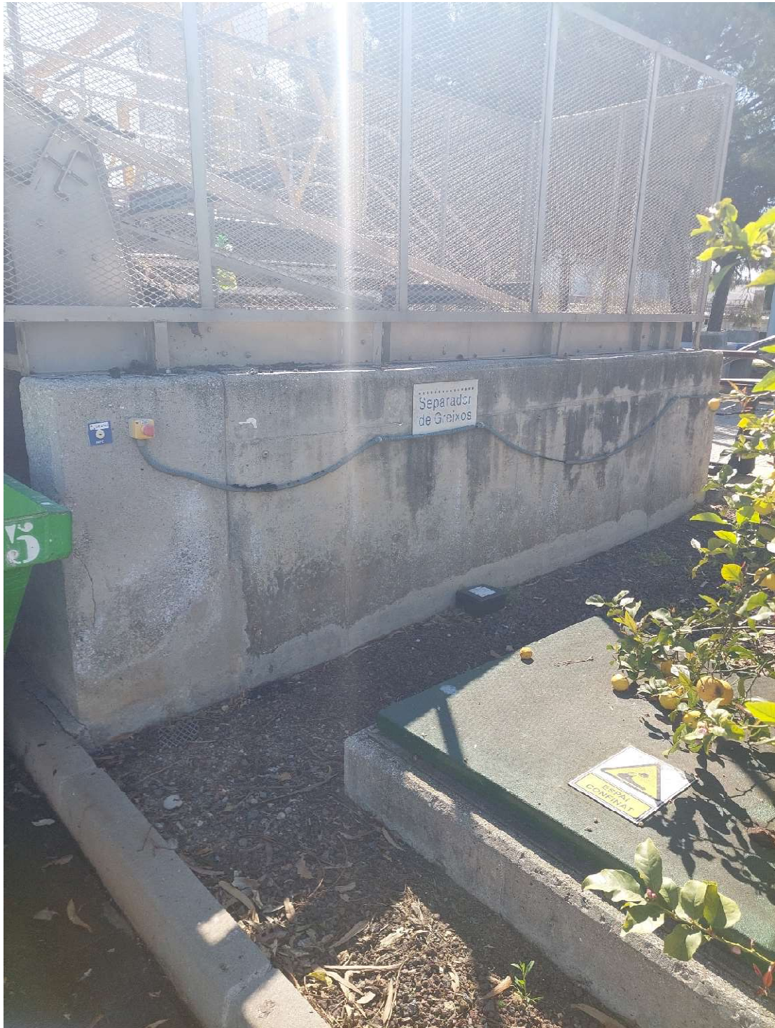
Foto Núm 2: Dipòsit a fer el passa murs, instal·lació nivell radar i boies
