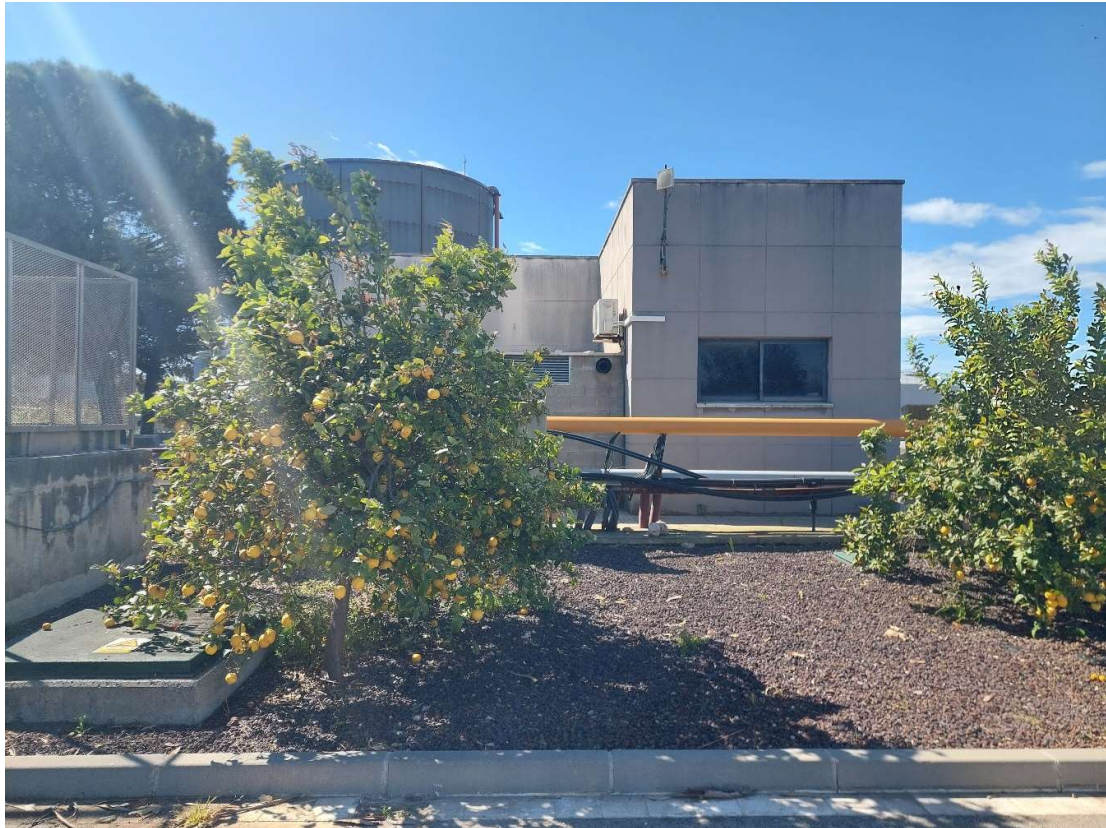
Foto Núm 1: Zona a instal·lar planxe de formigó i bombes
