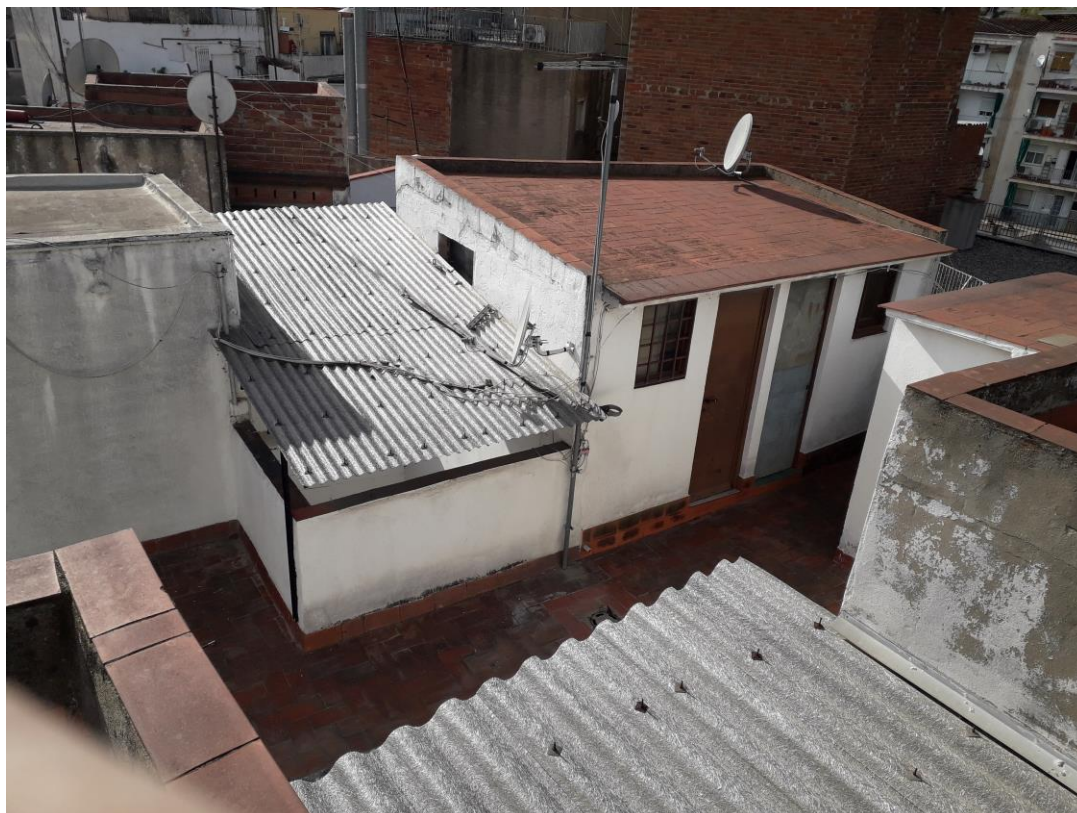
Dos detalls de l'estat de coberta
