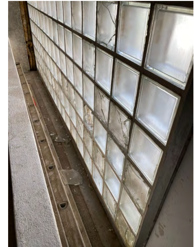
Vistes interiors façana carrer de Digoine on s'observen les peces amb trencament.
