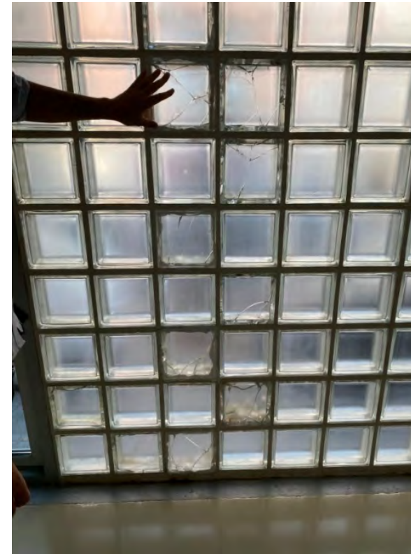
Vistes interiors façana carrer de Digoine on s'observen les peces amb trencament.
