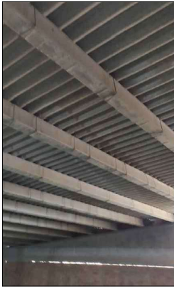
BIGUETES DE FORMIGÓ PRETENSAT
