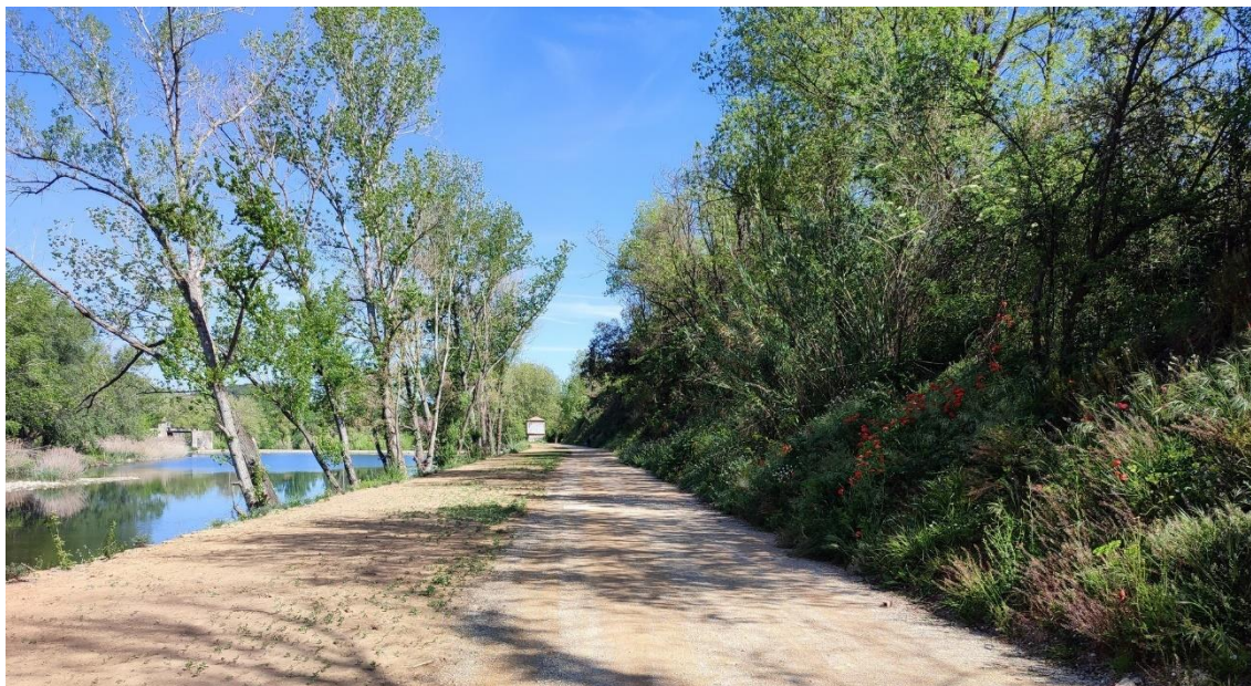
Figura 3: Vista de l'àmbit una vegada realitzats els treballs als col·lectors de sanejament.
