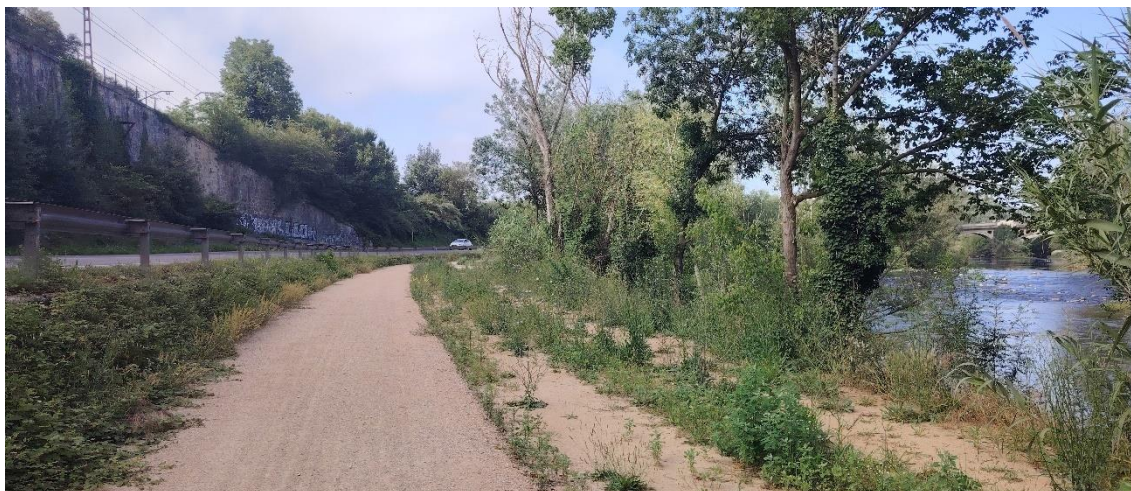
Figura 6: Estat actual de l'àmbit d'actuació amb el carril bici ja executat vist des de aigües amunt.
