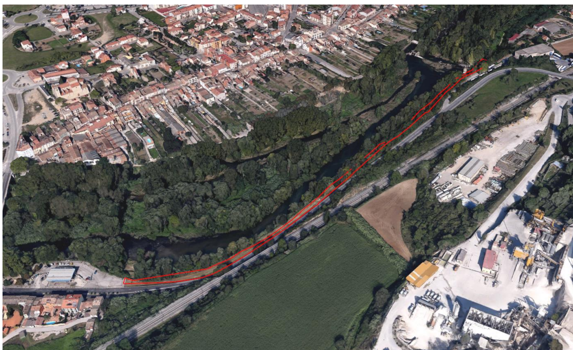
Figura 2: Vista d'ocell de l'àmbit d'actuació, des de l'aigua avall del Pont de l'aigua i aigua amunt de la resclosa de Can Torres.
