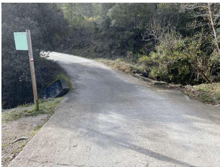
Actuació 4 (Obra de drenatge)
