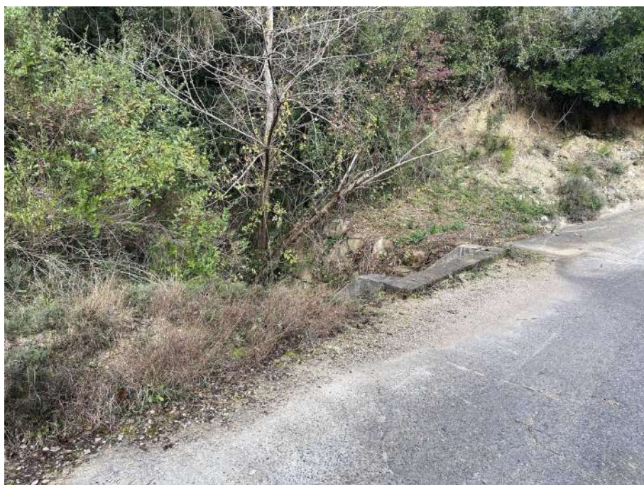
Actuació 4 (Obra de drenatge)
