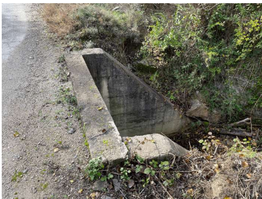
Actuació 4 (Obra de drenatge)
