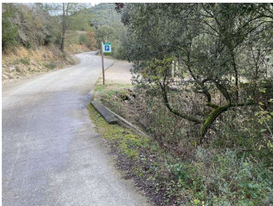
Actuació 4 (Obra de drenatge)
