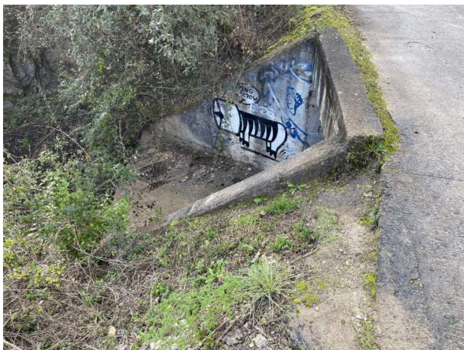
Actuació 4 (Obra de drenatge)
