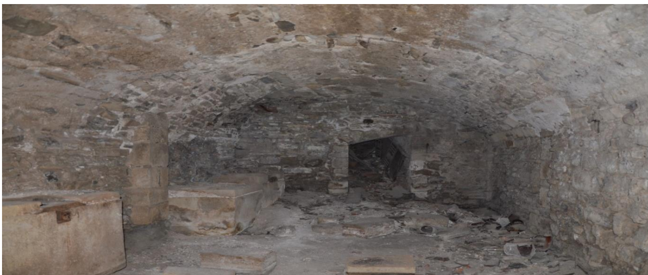
Celler de la casa núm. 7 de cal Pedrolo vist en direcció a la Plaça dels Comediants. Podem veure l'accés al celler, actualment obstruït per terres i runa, i un pilar estructural de la casa de cronologia antiga. A l'esquerra, les 3 piques d'oli.
