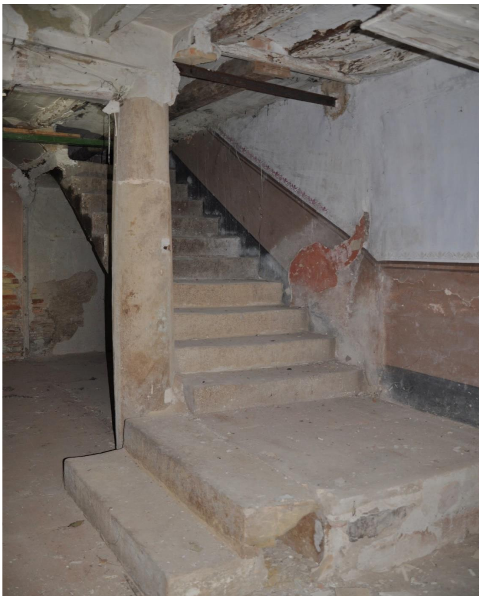
Escalinata d'aire senyorial d'accés al primer pis que mor sota l'embigat d'aquest per reformes posteriors
