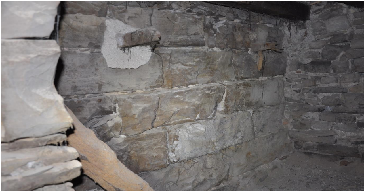
Paret mitgera feta amb carreus de calcària de grans dimensions disposats en filades regulars corresponents a una construcció prèvia d'època medieval que reaprofitava la casa núm. 7 del carrer Major
