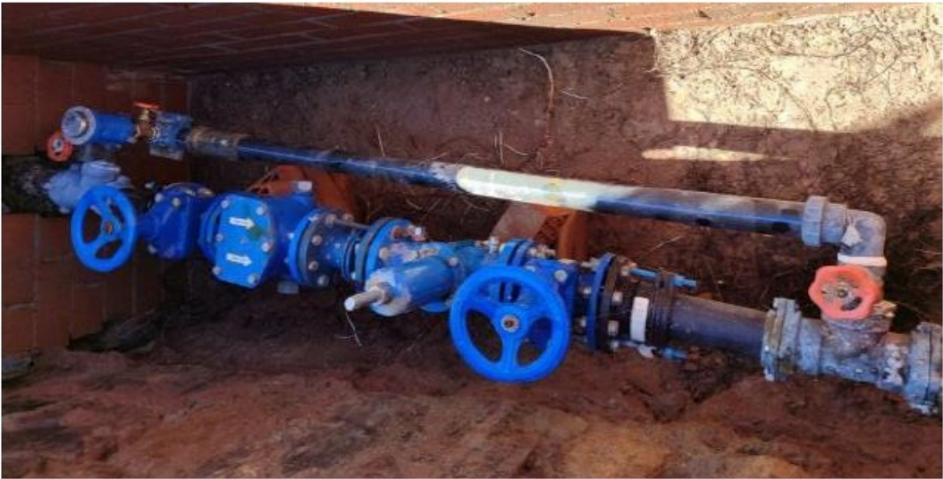
Exemple de conjunt DN80 amb by-pass
