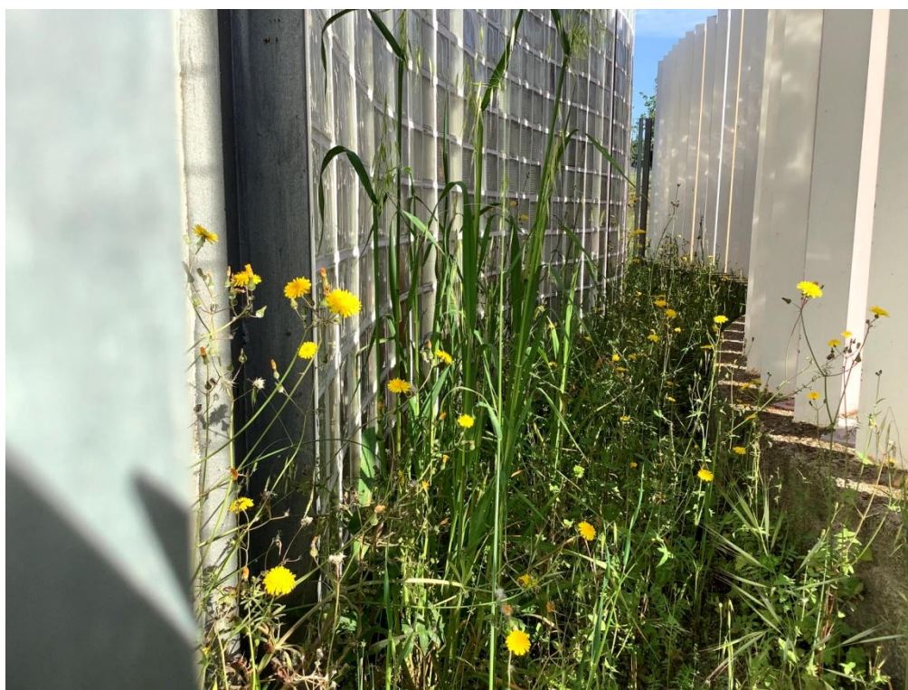
Detall de l'estat actual de la zona del pati exterior
