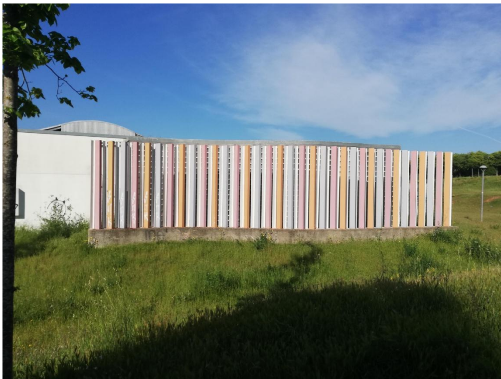
Vista general de la façana NE
