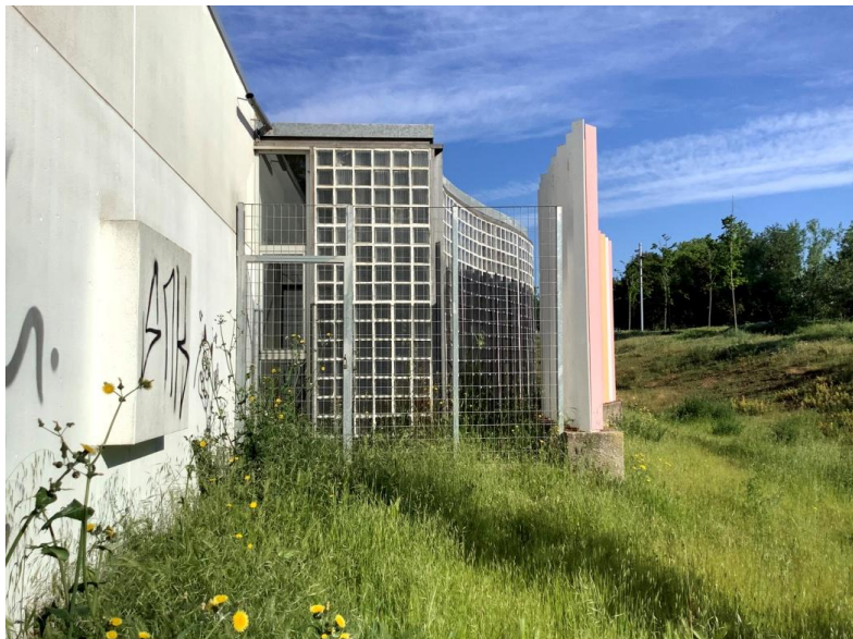
Estat actual del tancament de vidre emmotllat de la Biblioteca Municipal.
