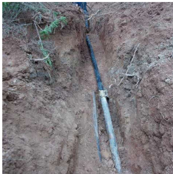
Il·lustració 4: Substitució de canalització
