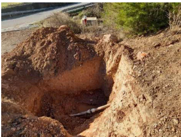
Il·lustració 2: Reparació ruptura tub
