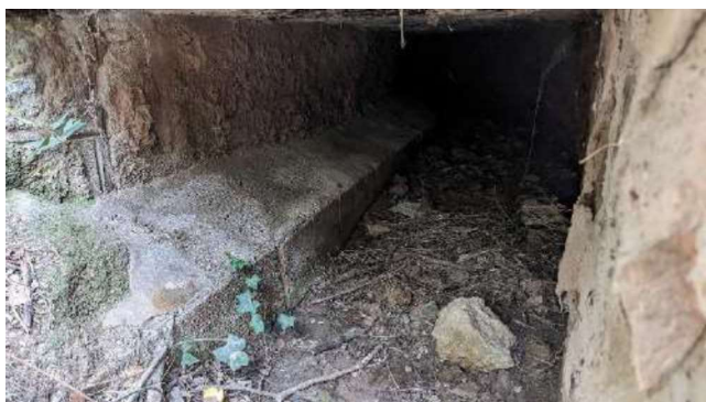
Il·lustració 12: Massissat de protecció de la beina
