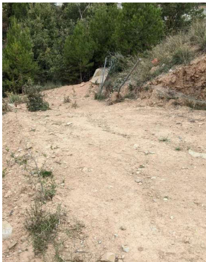
Il·lustració 9: Pou sud de creuament de la C-25 i inici de l'actuació
