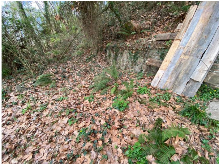
Fotografia 44. Vista de l'àmbit de la Font d'en Fàbrega.
