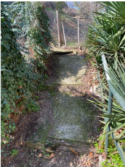
Fotografia 9. Vista de les escales sobre el carrer de la Font Alta cap al carrilet.
