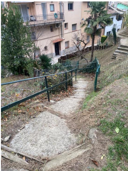
Fotografia 7. Vista de les escales sobre el carrer de la Font Alta cap al carrilet.
