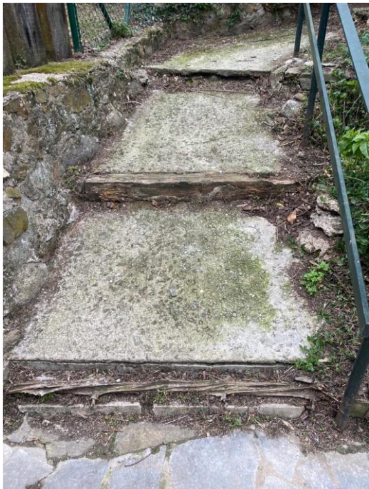
Fotografia 8. Vista de les escales sobre el carrer de la Font Alta cap al carrilet.
