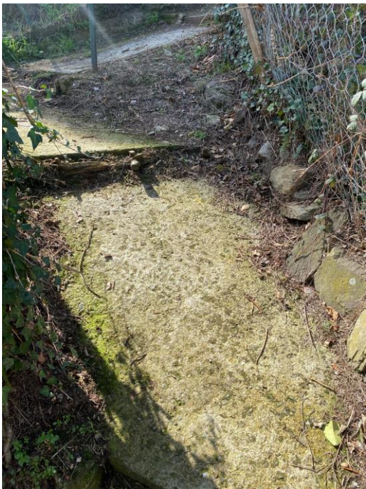
Fotografia 10. Vista de les escales sobre el carrer de la Font Alta cap al carrilet.
