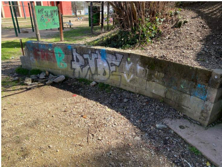
Fotografia 15. Vista de l'àmbit de la Font de l'Estació.
