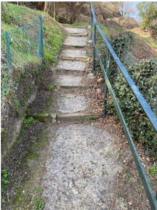
Fotografia 12. Vista de les escales sobre el carrer de la Font Alta cap al carrilet.
