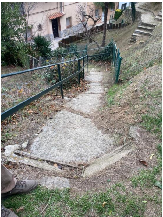
Fotografia 6. Vista de les escales sobre el carrer de la Font Alta cap al carrilet.
