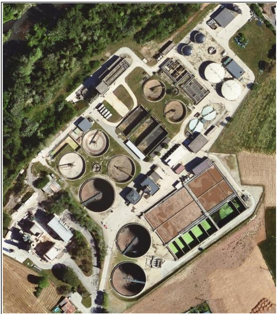
Figura 1. Vista aèria de l' EDAR de Girona i la PVE (incineradora) (Font: ICC 2025)
