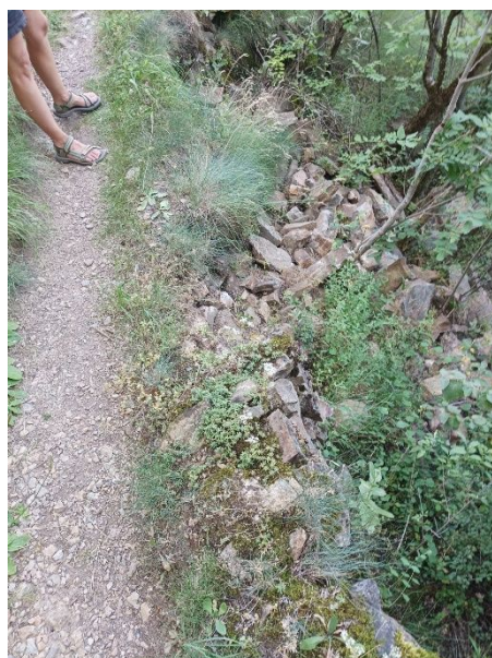
Mur de pedra seca situat al camí d'Olp a Altron: Coord: 42.438650,1.117246
