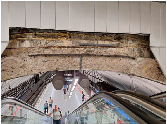
Foto7. Vista sobre escales mecàniques
