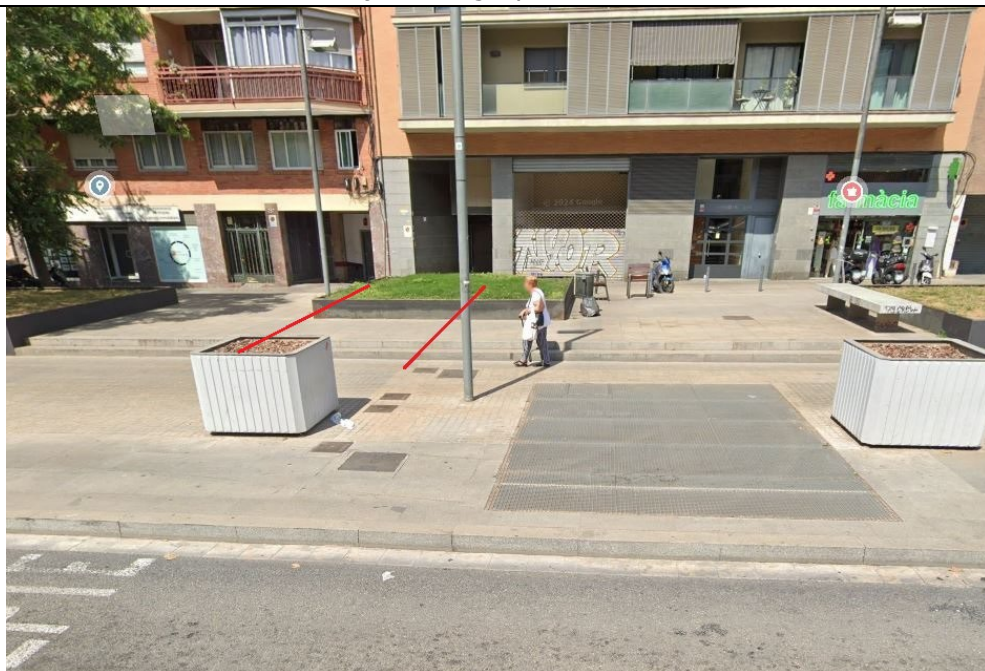
Foto12. Ubicació aproximada de la junta en vorera
