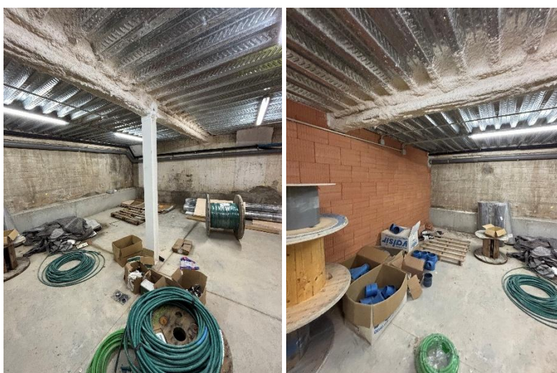
Sales instal·lacions i magatzems soterrani – murs de contenció
