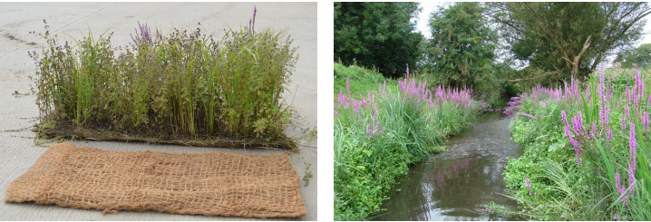
Figura 7. Imatges d'herbassars estructurats en fibra (prevegetats), abans (esquerra) i després d'implantació (dreta)
