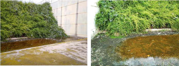
Figura 4 Estat actual de la bassa est a la biblioteca Jordi Rubió i Balaguer
