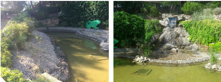
Figura 8. Exemple de bassa amb per gabions flexibles vegetables cilíndrics reblerts de graves i graves confinades
