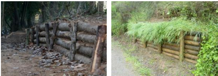
Figura 11. Exemple de palissades amb pals de castanyer i amb pal de fusta rodó
