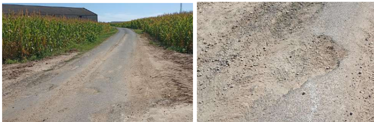
Figura 5. Estat actual de la via
