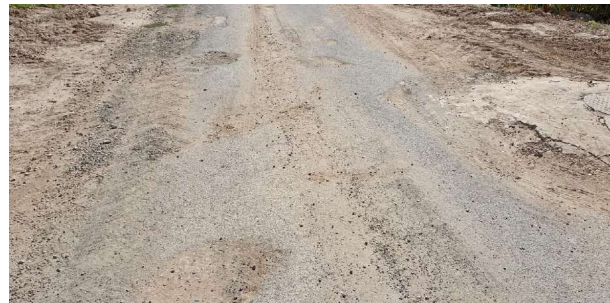
Figura 6. Estat actual de la via
