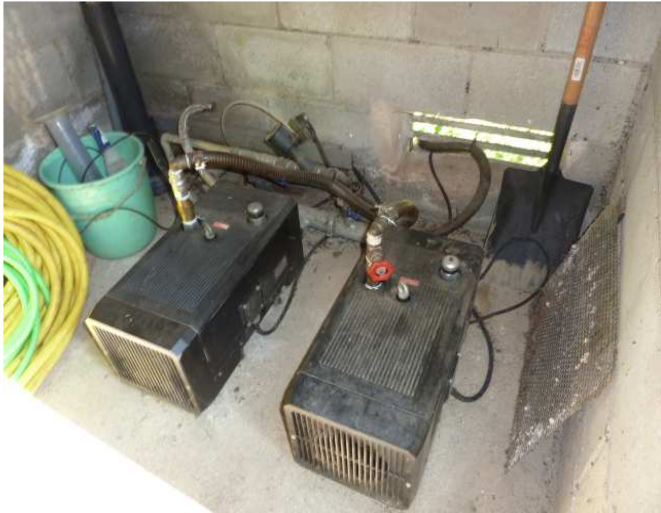
Bufants per a l'aireació del procés biològic. Mitjançant temporitzadors, s'alterna el seu funcionament.
